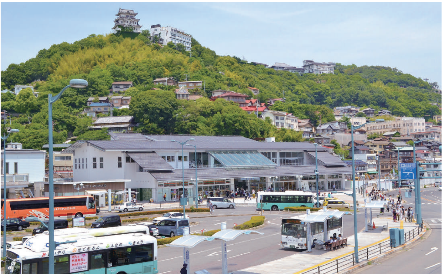
平成31年3月10日リニューアルオープンした尾道駅
